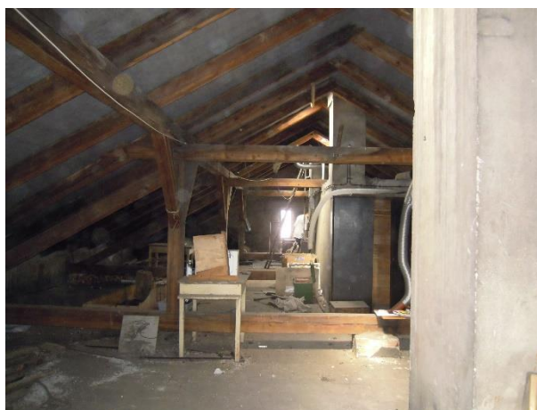
Obr. 5 - VB – Středové vaznice, sloupky a vazní trám
