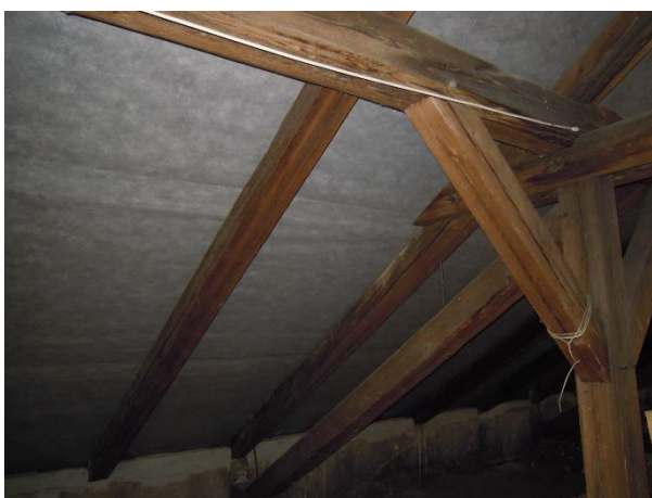
Obr. 8 – VB – Detail sloupku se šikmou vzpěrou
