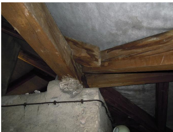
Obr. 7 – VB – Detail napojení úžlabí vikýře na vaznici
