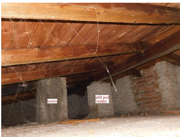
Obr. 10 - PŘÍSTAVEK- Podepření hřebenové vaznice
