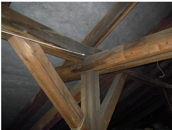
Obr. 6 – VB – Detail napojení vaznice a sloupku
